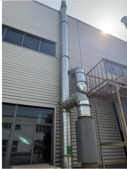
DA001 制芯、浇注废气排气筒
