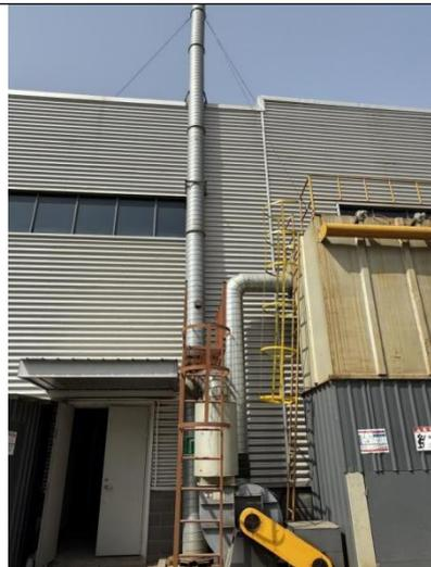
DA003 熔化废气排气筒
