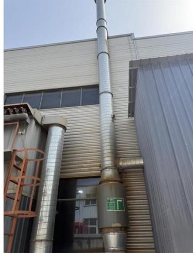
DA002 抛丸、打磨粉尘、落砂、砂回收废气排气筒
