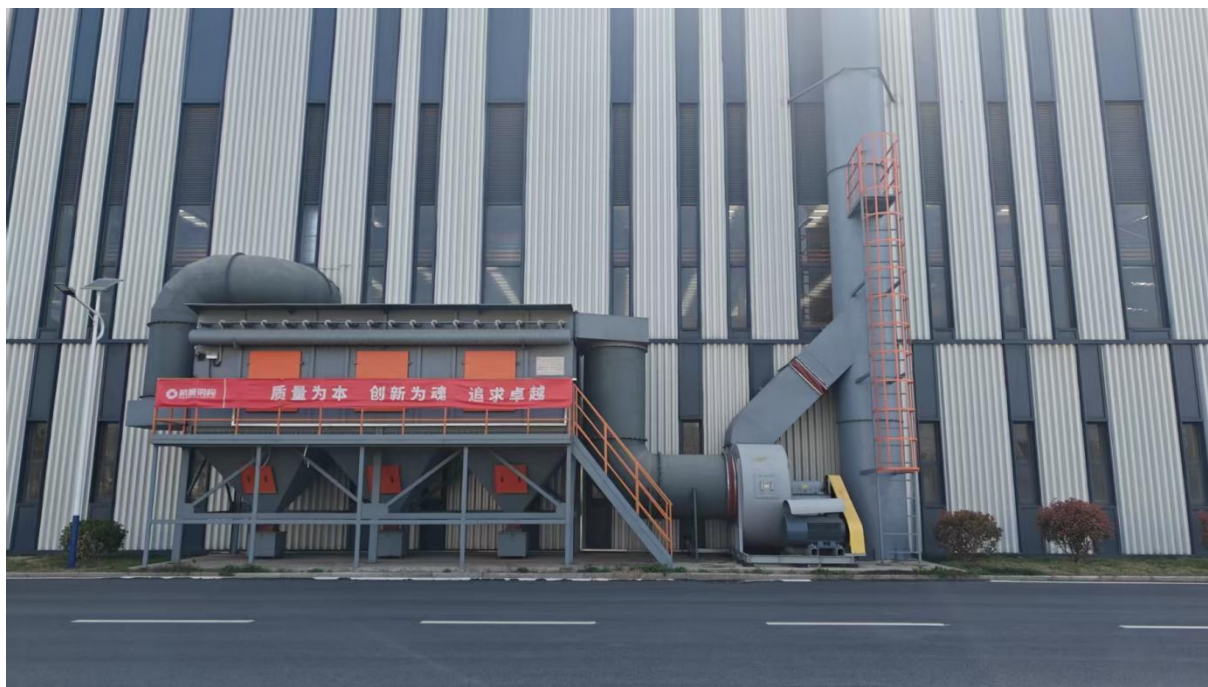
切割、打磨、焊接排气筒(DA004)及环保设备
