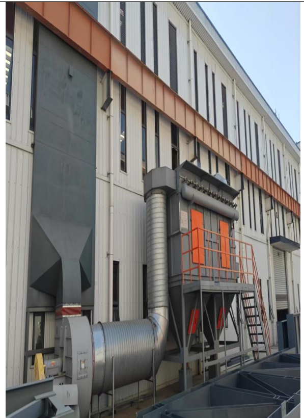
切割、打磨、焊接排气筒(DA007)及环保设备
