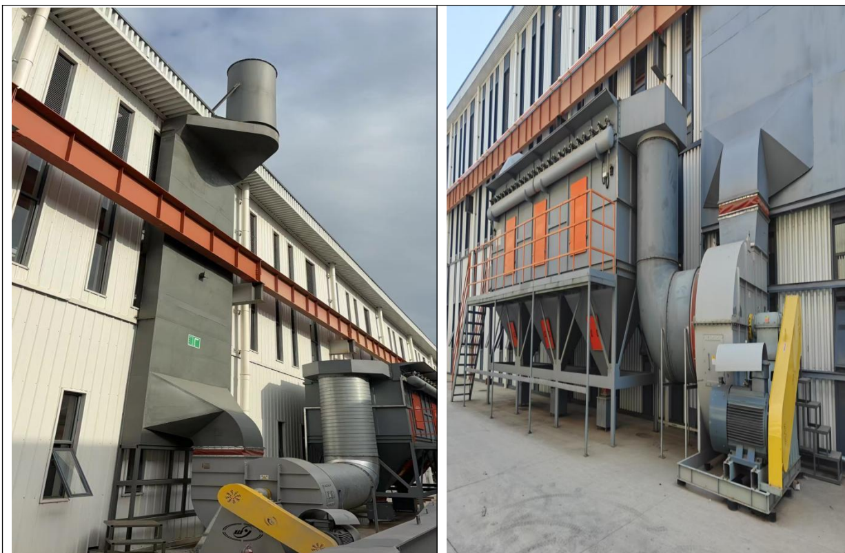
切割、打磨、焊接排气筒(DA008)及环保设备
