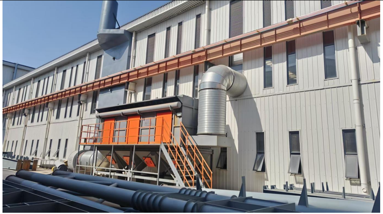
切割、打磨、焊接排气筒(DA006)及环保设备
