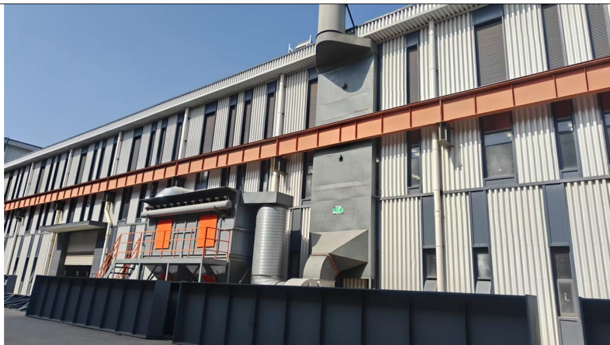
切割、打磨、焊接排气筒(DA005)及环保设备
