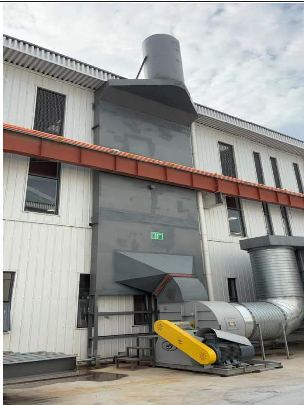
切割、打磨、焊接排气筒(DA007)及环保设备
