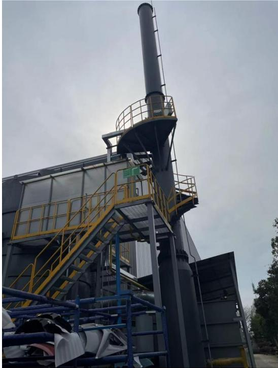
喷涂、流平、烘干、洗枪、洗枪、火焰处理及RTO系统燃烧废气排气筒（DA005）
