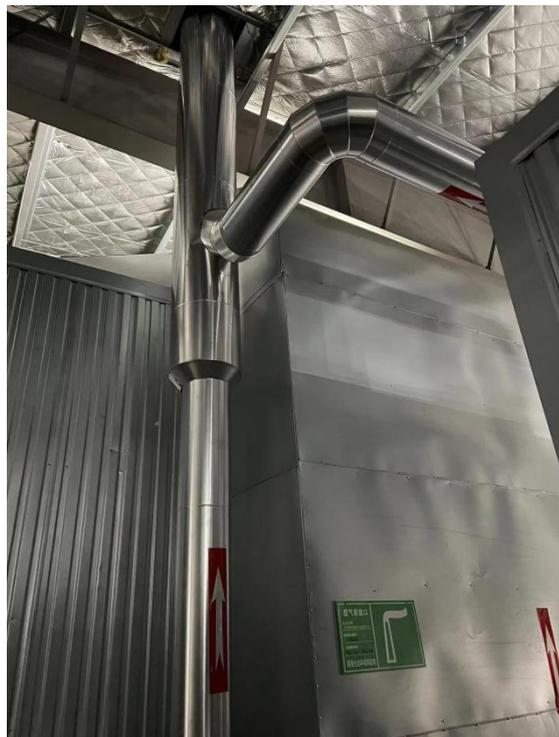
水分烘干炉天然气燃烧废气排气筒 (DA003) 喷涂烘干炉天然气燃烧废气排气筒 (DA004)
