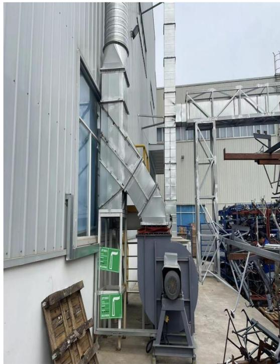
点补及点补烘干废气和危废暂存间废气排气筒（DA006）
