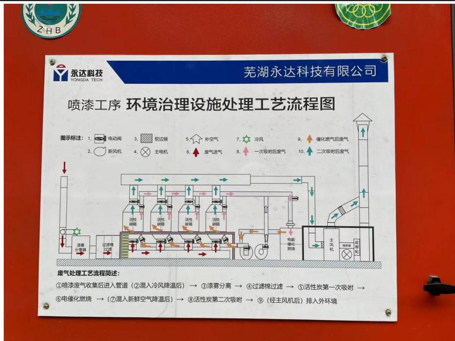
废气治理设施工艺流程
