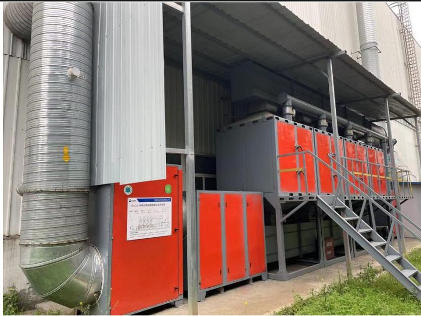
迷宫式漆雾分离器+过滤棉+冷却器+活性炭吸附浓缩+催化燃烧（电加热）废气治理设备
