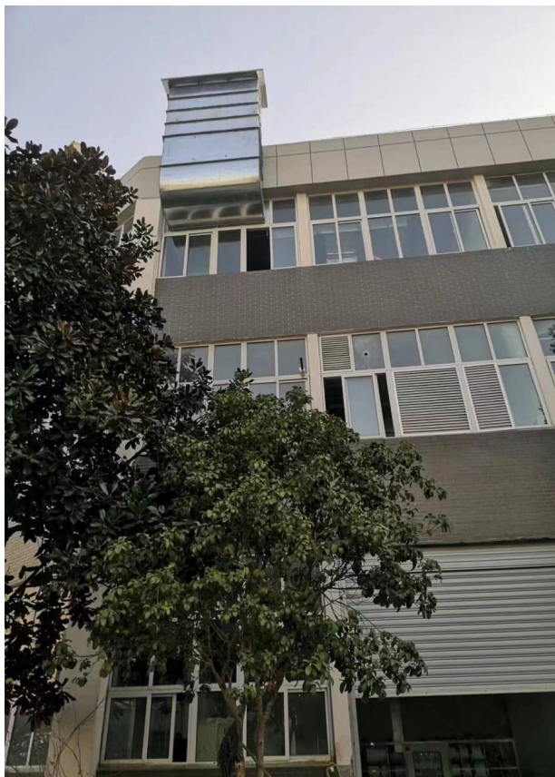
3、4#涂布生产线废气排气筒（DA003）
