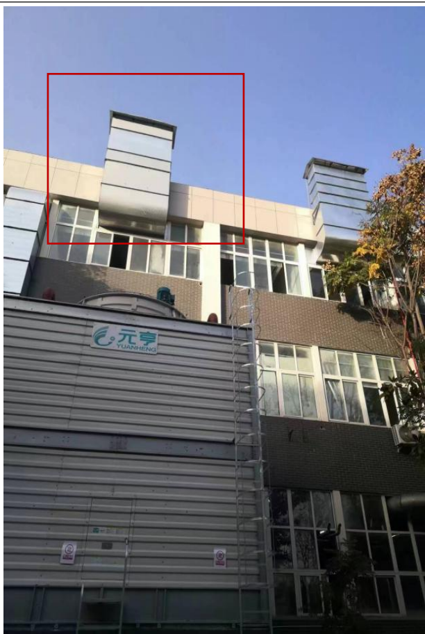
5、6#涂布生产线废气排气筒（DA004）
