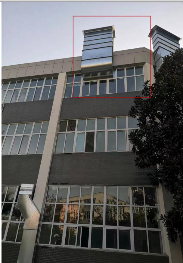
1、2#涂布生产线废气排气筒（DA001）
