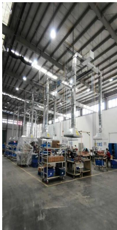
弯管焊接废气处理
