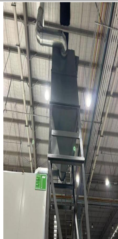
套管喷砂排气筒（3#）
