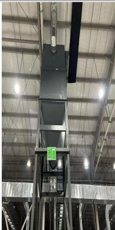
套管焊接排气筒（2#）
